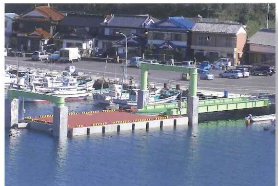
浮棧橋 連絡橋
