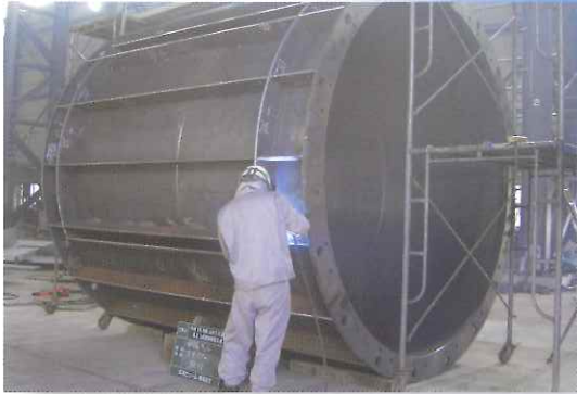
橋脚下部 鋼製ウエル
