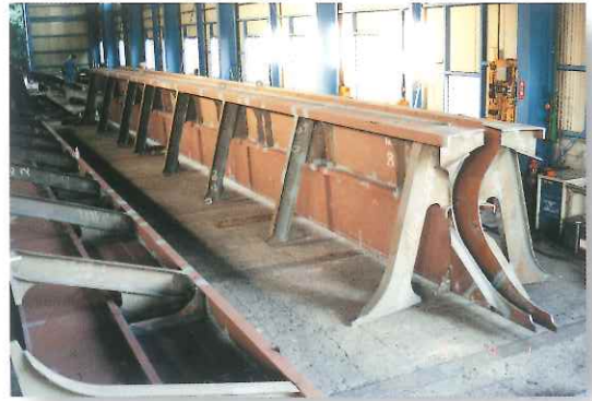
船体甲板ブロックハッチコーミング
