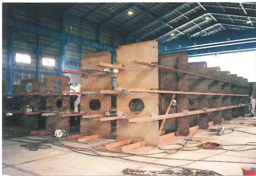
船底中央部フロア枠組
